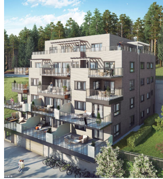
Nytt boligsameie. Komplekset Bergås terrasse. Drammen, Norge. ECOi / Aquarea
