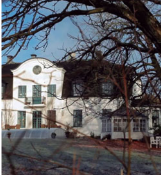
Disponentvillaaen: Bygningen er på 740 m 2 boflate og med ytterligere 460 m 2 loft og kjeller. Nord for Göteborg, Sverige. Aquarea
